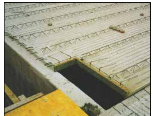
Abschalung im Randbereich bei Fertigteildecken
