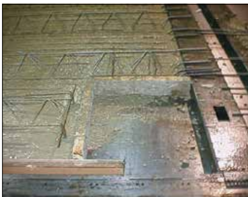
2. Betoniervorgang nach Abschalung
