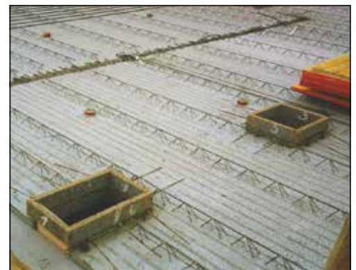
Abschalung in der Fläche
