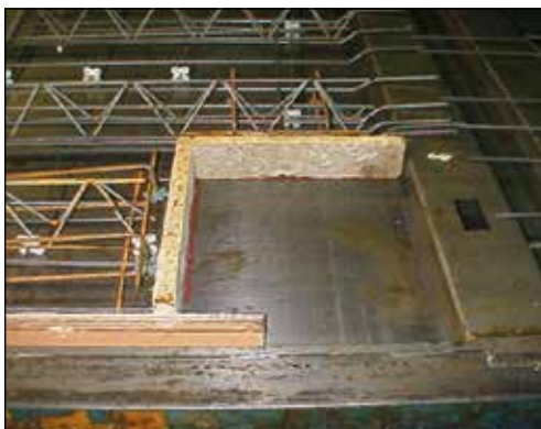
1. Abschalung im Randbereich bei der Produktion von Fertigteildecken
