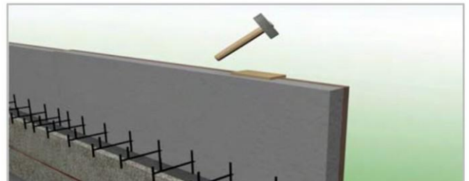
Pressstoßen, um Fugen zu minimieren
